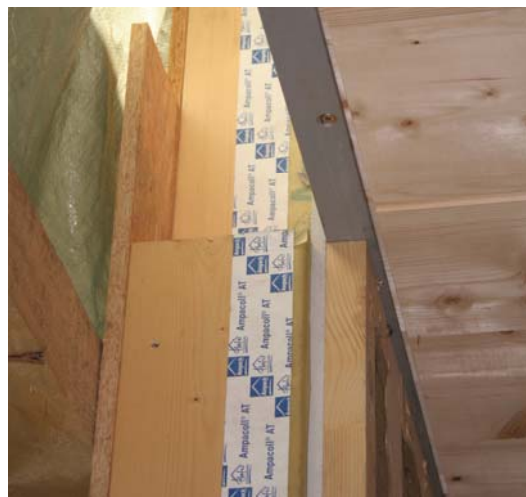
Dettaglio dell'appoggio della soletta
