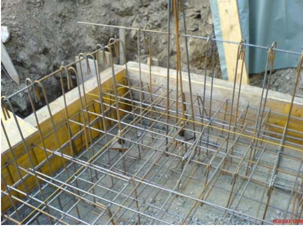
Dettaglio testa micropali nella platea di fondazione
