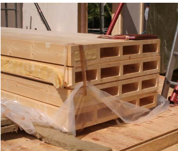
Dettaglio elementi per soletta
