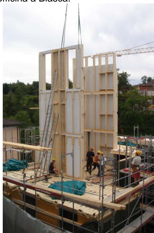
Posa del corpo centrale con elementi alto 9m
